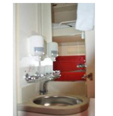
lavabo privé dans chaque cabine douche dans les chambres des hôtels de jour
